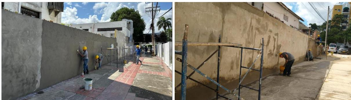
En cuanto a los trabajos de fondeo se generó un cubrimiento de 343 m<sup>2</sup>, se aplicaron sellantes especializados para cubrir porosidades y asegurar la adherencia de las pinturas, utilizando tecnología de aplicación airless y
